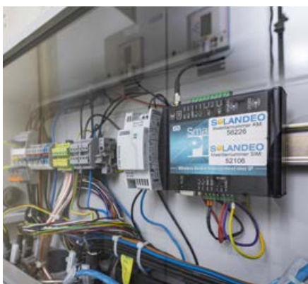
Hardware: Die von Solandeo in den Schaltschränken des Batteriespeichers verbauten Smartmeter, die Stromdaten an die Zentrale senden. Die Aufnahmen zeigen Schaltschränke im Batteriespeicher
