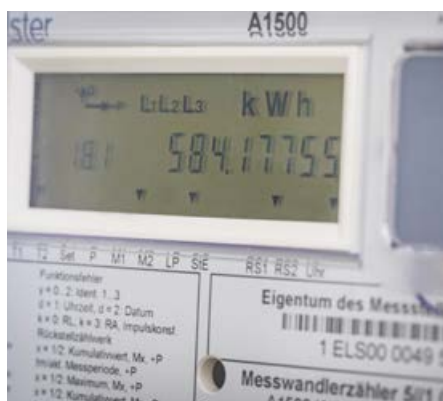
Hardware: Die von Solandeo in den Schaltschränken des Batteriespeichers verbauten Smartmeter, die Stromdaten an die Zentrale senden. Die Aufnahmen zeigen Schaltschränke im Batteriespeicher
